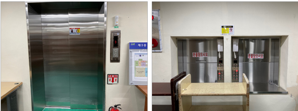
[그림 3-19] 노후 승강기 교체 후(좌-화물용 승강기, 우-덤웨이터)
