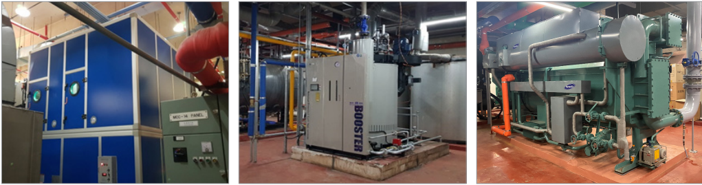
[그림 3-18] 노후 기계설비 교체 후(좌-향온항습기, 중-보일러, 우-냉동기)
